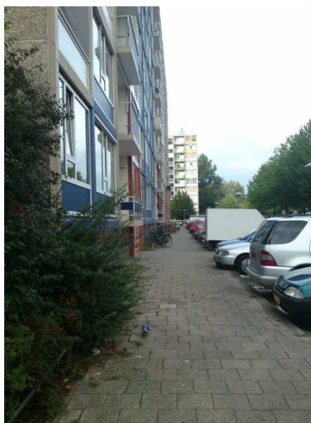
Stoep, gezien van portiek 1 naar 4
