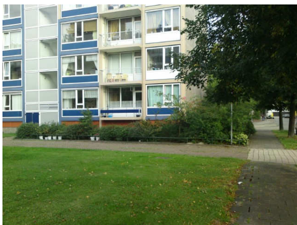
Achterkant, ter hoogte van portiek 1
